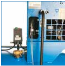
Secador preinstalado y conectado
